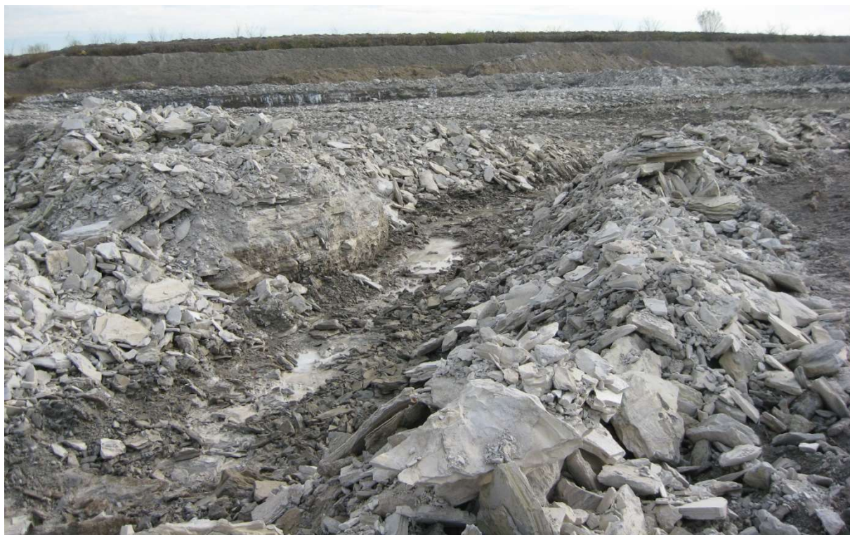
7. ábra: Az erőmű zagyártározóján lerakott és a 2010 nyári gátmagasításhoz visszafejtett szürkeiszap [Grey sludge of the Ajka power plant used to the heightening of the dam in summer 2010] (Vatai J., 2010. nov. 5.)
