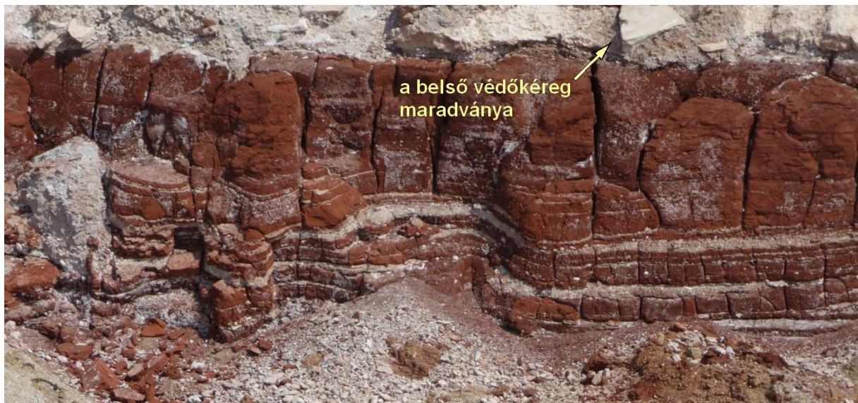
5. ábra: Az északi fal kizökkent darabjának alja a tározó felől [The bottom of the off-moved fragment of the north wall] (Fügedi U., 2011. máj. 19.)
