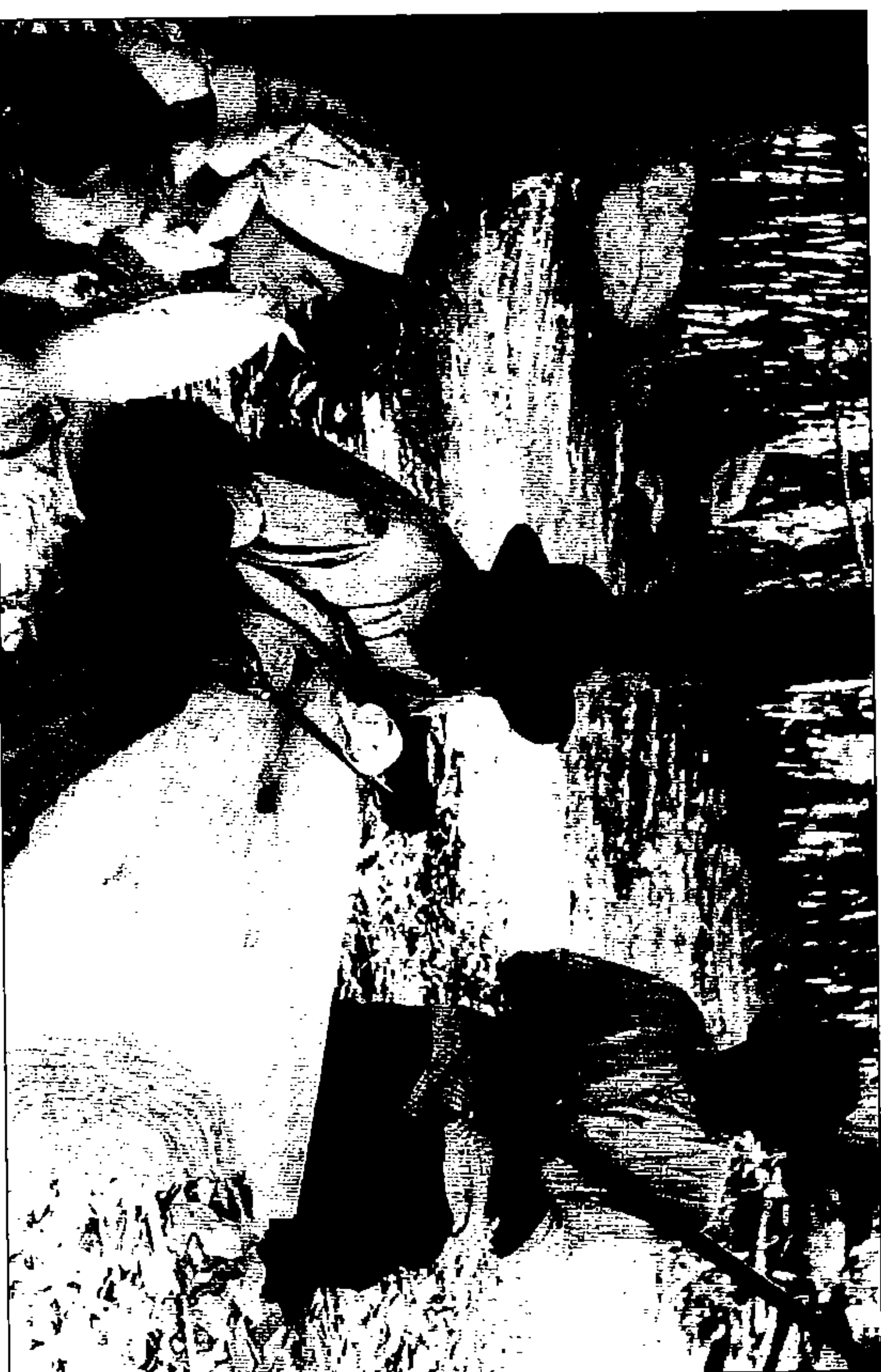
Teknővájás, a teknő külső oldalát vonókéssel simítják le.
